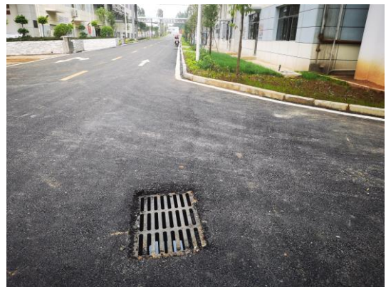
场内道路硬化、绿化、雨水口
