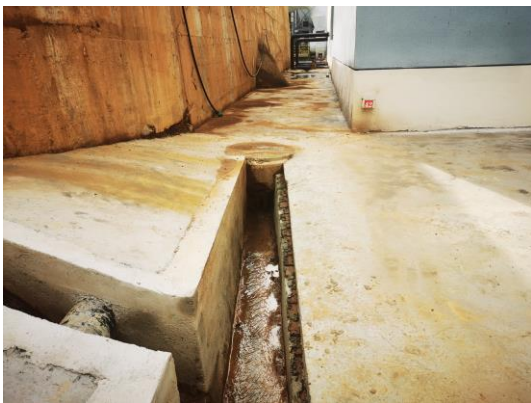
排水沟及检查井
