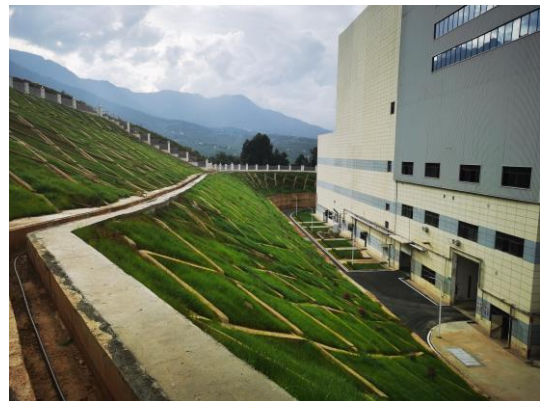
框格护坡、绿化及排水沟
