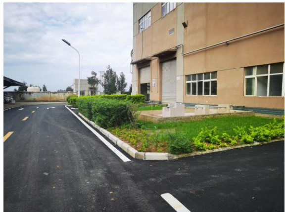
场内道路硬化及绿化
